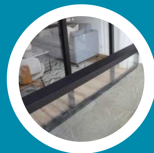
BARANDA DE VIDRIO CON ANTEPECHO DE FIERRO
